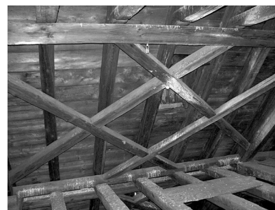
Figura 2.5.c. – Sistem de diagonale duble XX – Biserica Sf Michael, Bamberg, Germania
