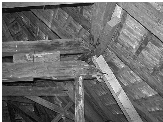
Figura 5.1. – Intervenții neprofesionale pe șarpanta cu caracter baroc a bisericii unitariene din satul Bădeni, județul Cluj.
