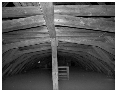
2.5.a. ábra – Íves mellszorító – Jezsuita templom, Bamberg, Németország
