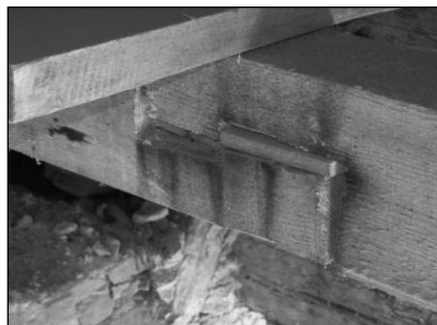
Fig. 5.5.b. — Détail de continuité mal exécutée, sans respecter le plan
