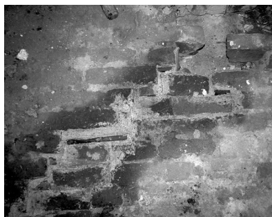
Figura 5.5.a. – Rețesere de boltă, realizată de maiștri specializați angajați de antreprenorul general – Tileagd, Școala cu clasele I-VIII;
