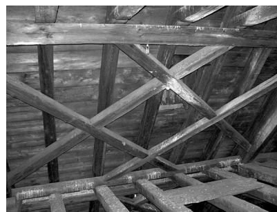
2.5.c. ábra – Kettős átlós XX merevítő rendszer – St. Michael templom, Bamberg, Németország
