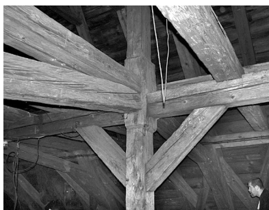
2.5.b. ábra – Keményfából készült függesztőrúd – St. Michael templom, Bamberg, Németország
