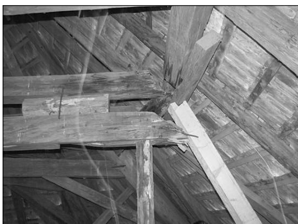
Fig. 5.1. — Interventions non-professionnelles sur la charpente à caractère baroque de l'église unitarienne du village de Bădeni, département de Cluj
