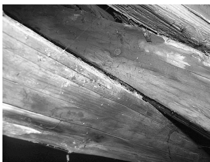
2.4.ab. ábra – A kolozsvári Kogălniceanu (Farkas) u. 6. alatti ingatlan fedélszerkezete – a szarufa helyzete a merevítőrendszer vízszintes hosszanti eleméhez viszonyítva
