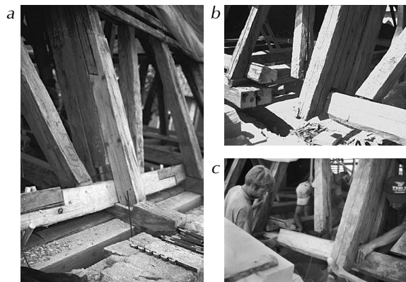
5.2 a-b-c ábra – Minimális beavatkozás, a biológiailag károsult részek helyettesítése – Bethlen Kollégium, ACTT 2000 (TTA+IHBC)
