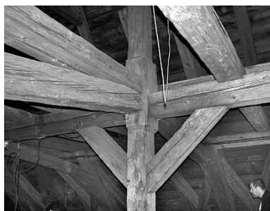
Figura 2.5.b. – Bară de agățare din lemn de esență tare – Biserica Sf Michael, Bamberg, Germania
