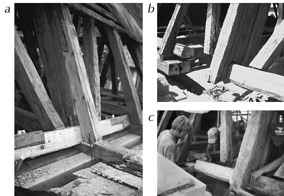
Figura 5.2. a-b-c – Intervenții minimale, înlocuirea porțiunilor de elemente biologic degradate – Colegiul Bethlen, ACTT 2000; (FTT+IHBC).
