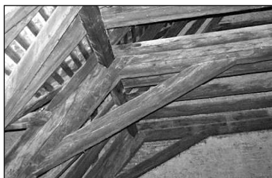
Fig. 2.3.a. — Assemblages faux entrait — aisselier — arbalétrier — charpente de l'immeuble de Cluj-N., 6 rue Kogălniceanu
