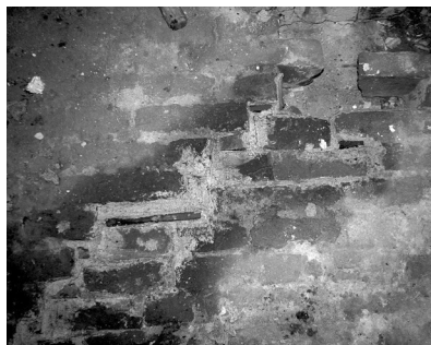
5.5.a ábra – A mezőtelegi általános iskola boltozatának a fővállalkozó által felkért, szakosodott mesterek által elvégzett összeszövése
