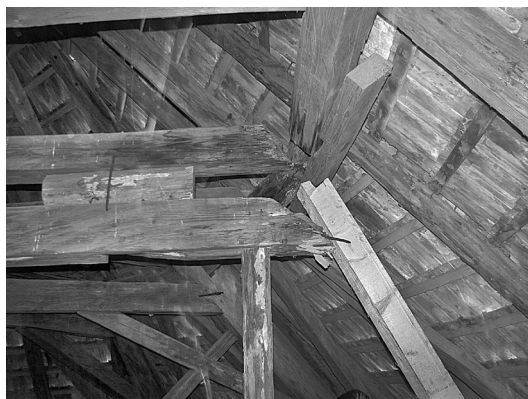
5.1. ábra – Szakszerűtlen beavatkozás a Kolozs megyei, bágyoni unitárius templom barokk fedélszerkezetén.
