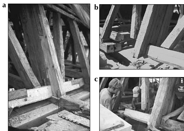
Fig. 5.2.a-b-c — Interventions minimales, remplacement de portions d'éléments avec des dégradations biologiques — Collège Bethlen, ACTT 2000, (FTT+IHBC)
