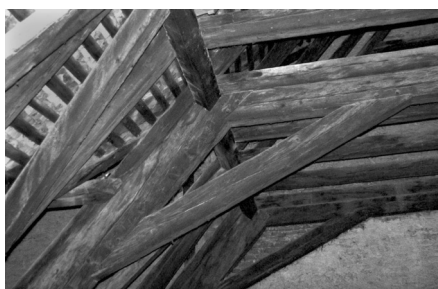
Figura 2.3.a. Îmbinările antretoază – colțar – arbaletrier – șarpanta imobilului str. Kogălniceanu nr. 6, Cluj-N.
