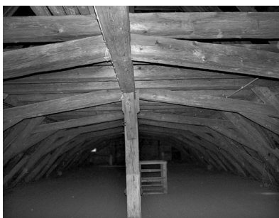
Figura 2.5.a. – Antretoază sub formă de arc – Biserica lezuiților din Bamberg, Germania
